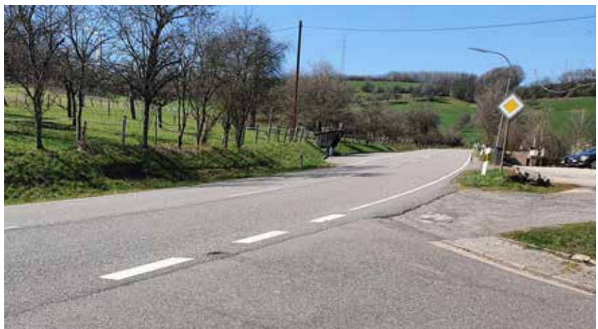
Missstand: fehlende Wegeverbindung vom Ortskern hin zur an der L 170 gelegenen Bushaltestelle
