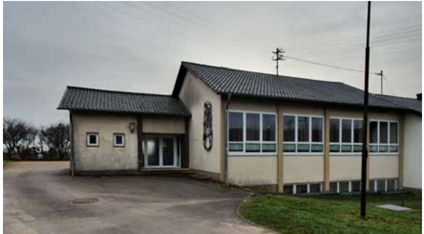
Bürgerhaus samt Vorflächen mit Sanierungs- und Aufwertungsbedarf im Bereich der Lilienstraße
